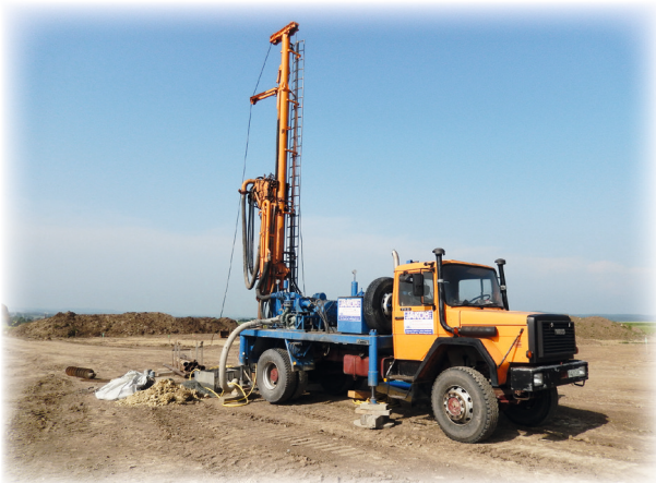
Bohranlage für Grundwassermessstellen
