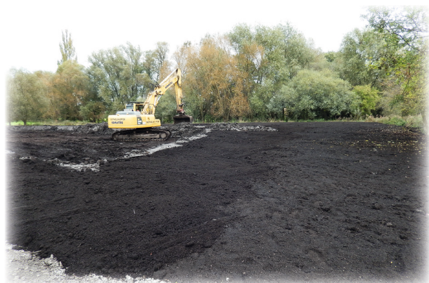
Das behandelte Erdreich wird auf einer Schicht Kompost wieder auf die Fläche aufgebracht
