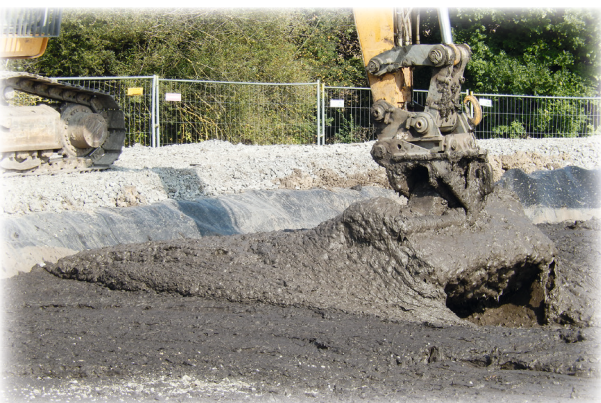
und anschließend mit Wasser vermischt
