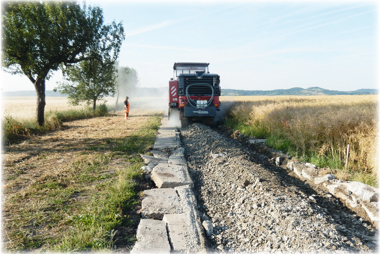
Bearbeitung des Betonplattenweges nach erfolgter Kampfmittelräumung
