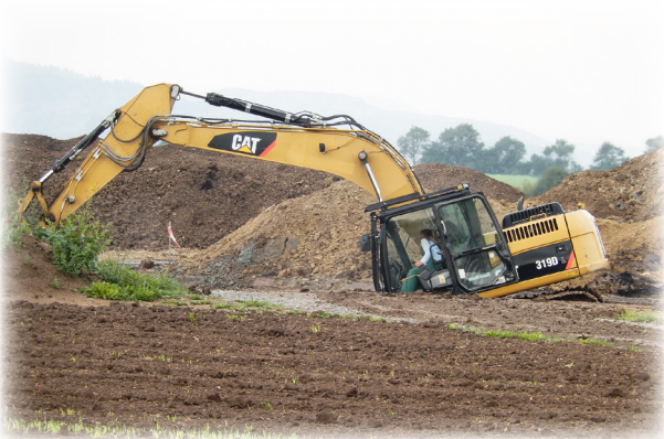
Baggerarbeit im Trichter
