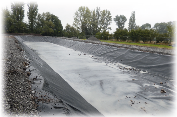
Erdbecken mit Deponiefolie abgedichtet
