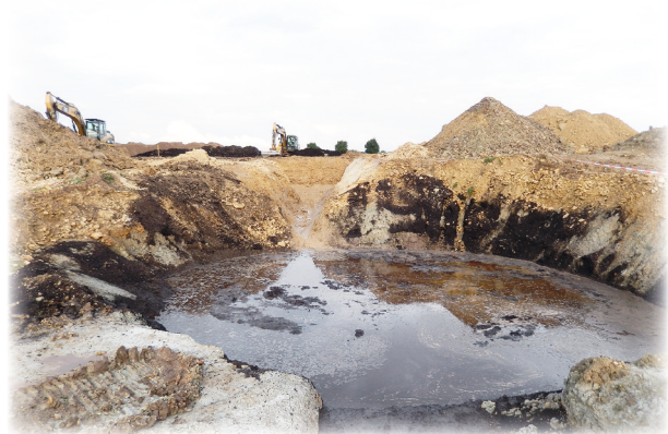
Wasser im Trichter sorgt für Schwierigkeiten bei der Bodenbearbeitung nach der Rekultivierung
