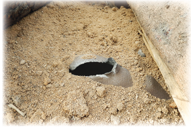
Ein Granatsplitter hat das ca. 1 cm starke Schutzrohr durchschlagen
