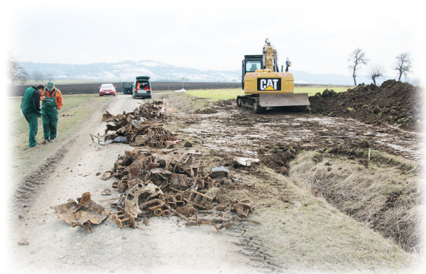
Allerlei Unrat wird zu Tage gefördert
