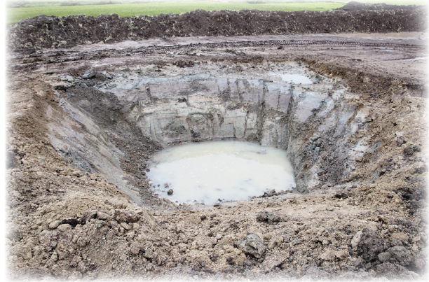
Grundwasser erschwert die Arbeit
