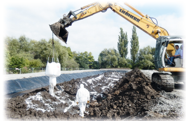
Kontaminiertes Erdreich wird eingefüllt und behandelt
