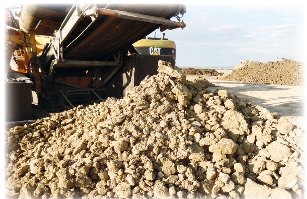
Grobfraktion der Siebanlage
